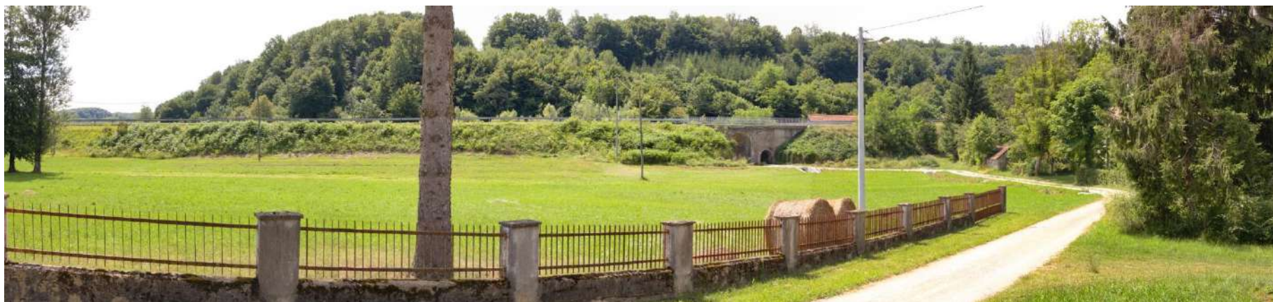
Sl. 3.12-15. Točka 10: Panoramska snimka lokacije izgradnje zahvata u blizini naselja Lišnica, pogled na jugoistok i postojeću DC3
